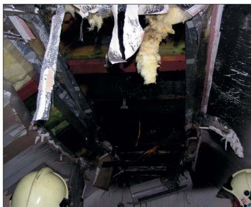
Obr. 1. Požár hotelu, který byl způsoben bleskovým proudem o hodnotě 111 kA
