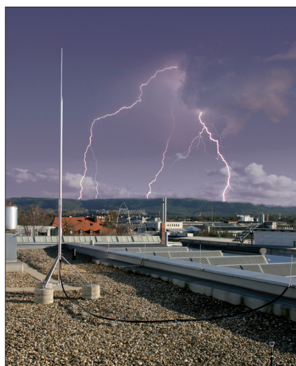
Obr. 2. Instalace vodiče HVI power
